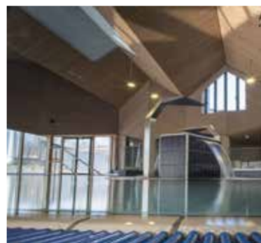
Piscine de Chambéry Application de vernis intumescent
