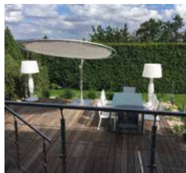
Création d'une terrasse pour maison 18e
