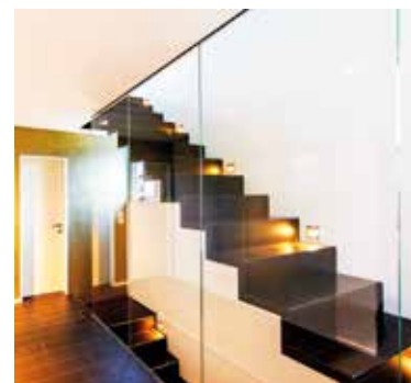
Escalier marches contre marches, garde-corps full verre, porte d'intérieur
