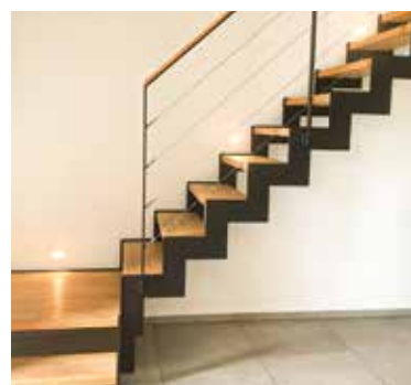
Escalier Fera métal et bois, garde-corps en inox
